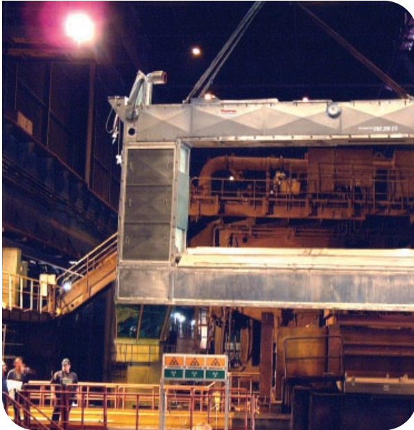
RM 306 ES während der Installation im Gerüst
